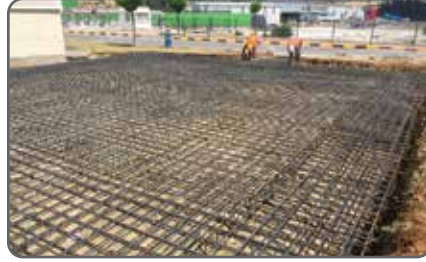
FRITOLAY TARSUS FABRİKASI KAİDE BETONU İŞLERİ MERSİN
