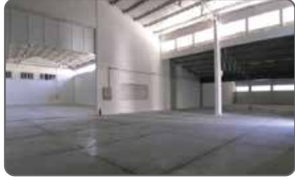
HAKAN GIDA SERBEST BÖLGE DEPOSU ONARIM GÜÇLENDİRME İŞLERİ MERSİN
